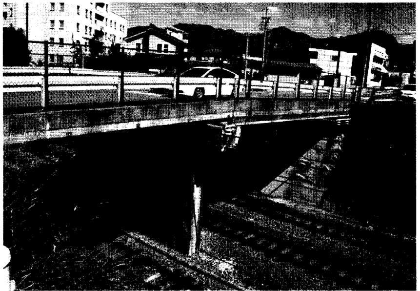
弁慶橋 (S.48年建設、鉄道跨線橋)
