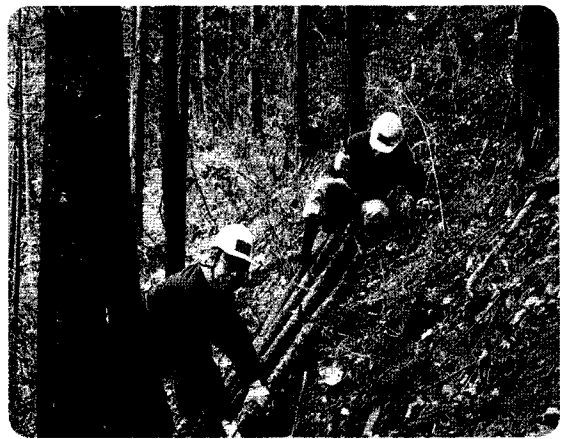
道づくりの作業現場
